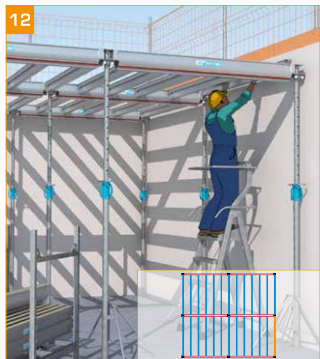
- Alle Nebenträger für diesen Abschnitt installieren.
