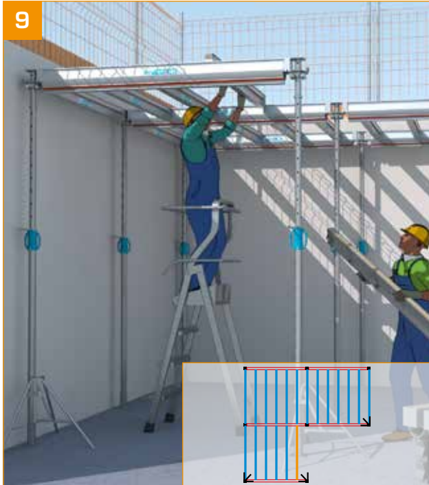
- Stück für Stück mit der Installation der Nebenträger fortfahren.
